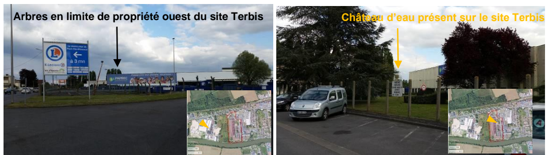
Figure 4-5 : Vue du site Terbis depuis la société Paprec
