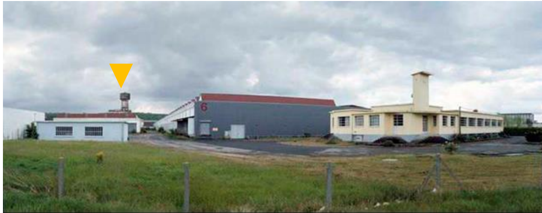
Figure 4-4 : Vue du site Terbis depuis la rue Pasteur
